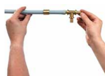
Рис. 16. Подготовка трубы и фитинга к запрессовке
