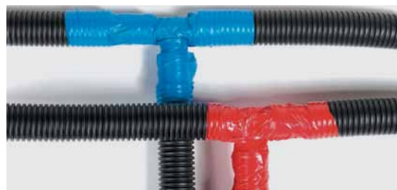
Рис. 21. Изоляция соединений
