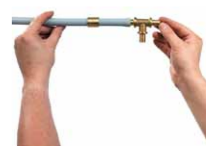
Рис. 16. Подготовка трубы и фитинга к запрессовке
