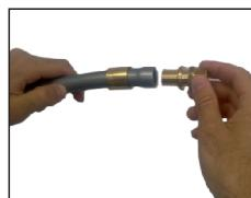
**5.** Выбрать насадки с маркировкой соответствующей диаметру трубы. Насадки удерживаются в инструменте с помощью фиксирующих болтов, которые могут быть вынуты усилием руки без применения специального инструмента. Для создания соединения, поместить подготовленное муфтовое соединение (трубу вместе с пресс-кольцом и фитингом) между пресс-головками.
