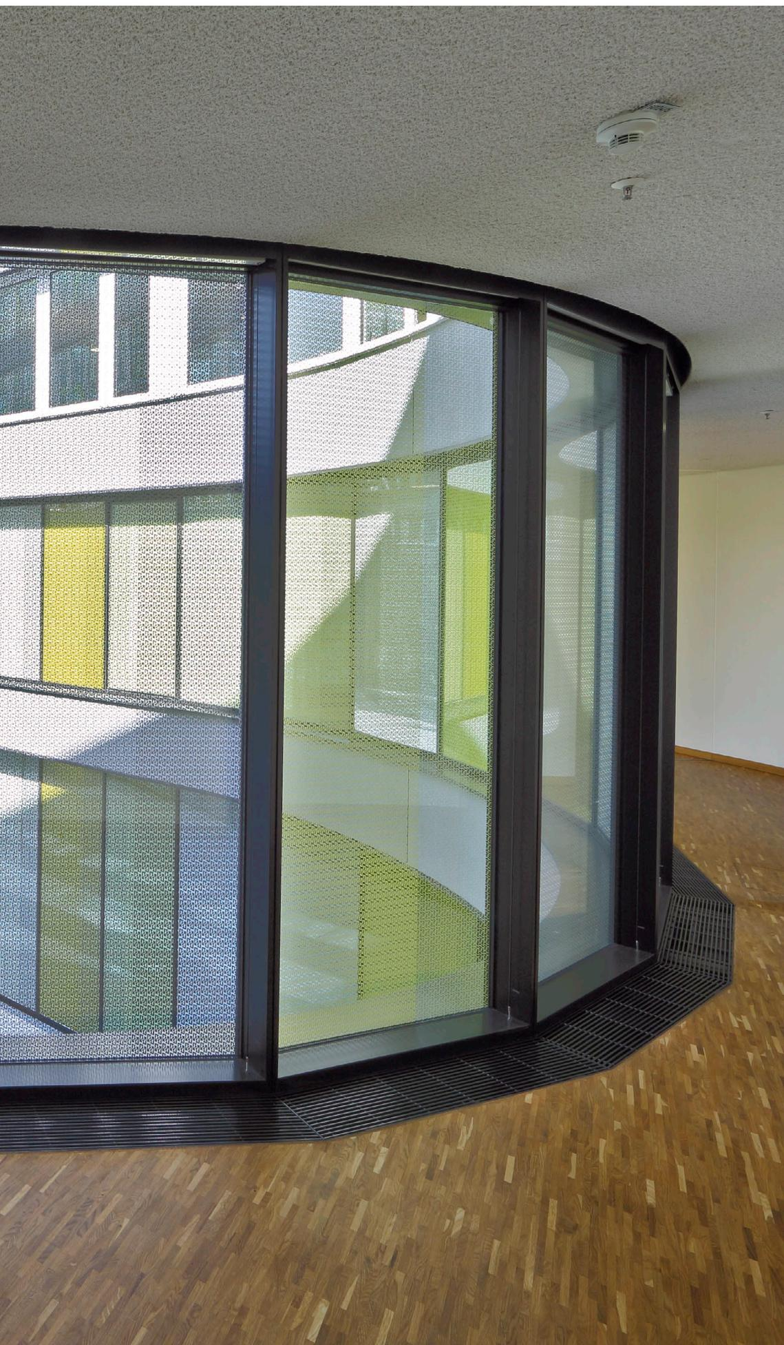
В новом здании компании ADAC в Мюнхене были применены каналные фанкоилы Katherm HK с энергоэффективными диаметрными ЕС-вентиляторами, с функцией плавного регулирования скорости вращения и энергосбережения. Прибор в данном исполнении подает из пола в помещение обработанный, нагретый или охлажденный воздух в режиме рециркуляции.
