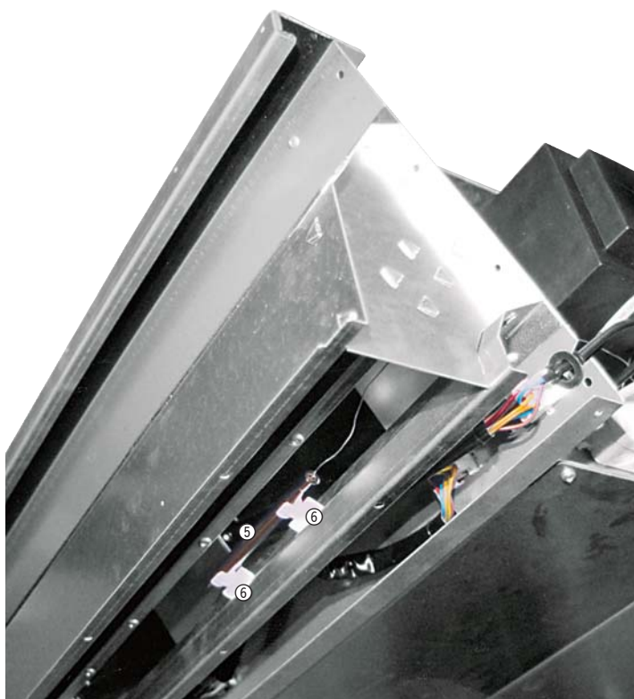
Монтаж датчика температуры воздуха на выходе
